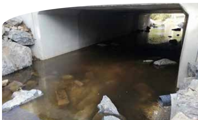
Remplacement d'ouvrage avec reconstitution du matelas alluvial
