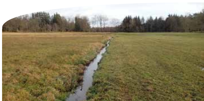
Fig.4 cours d'eau recalibré
