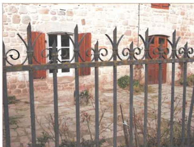
Margerides : Cour dallée (Maison XVIIIe s.)
