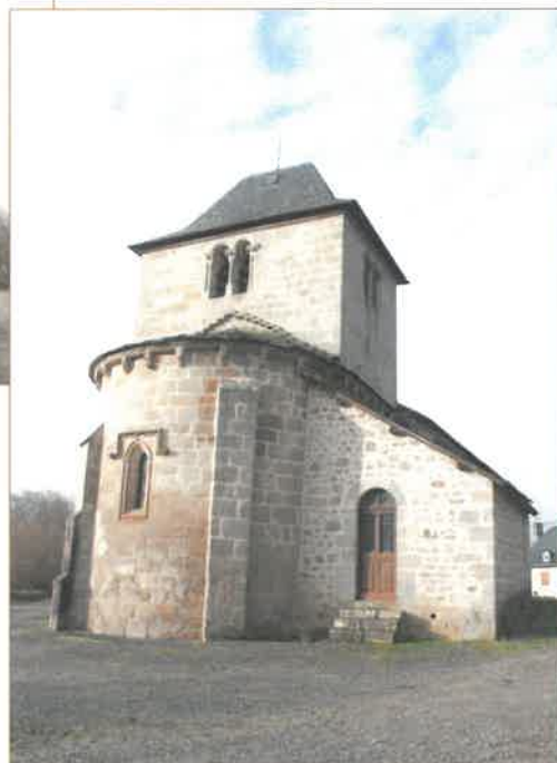
Margerides : Église - façade Est
