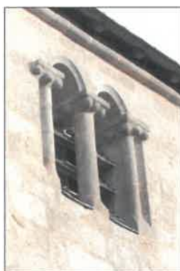
Baie géminée à colonnettes
