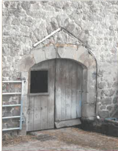
Margerides : arc de décharge (grange)
