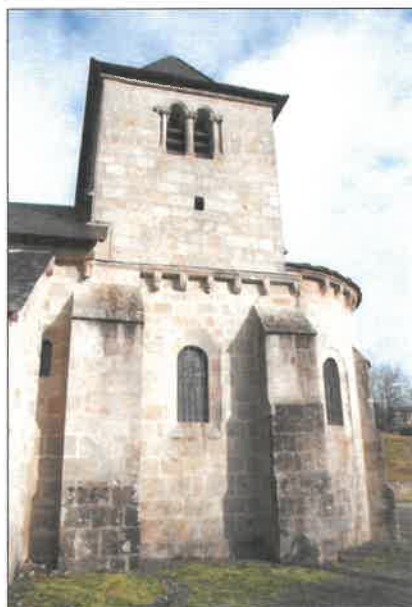
Clocher rectangulaire à baies géminées
